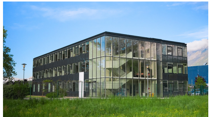
Centre de télésurveillance Atral Services à Crolles (38)
